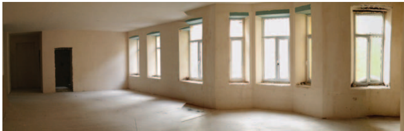
На фото: Внутренние помещения института на Лахтинской, подготовленные к отделочным работам. Вверху слева: Ведутся работы во внутреннем дворе института.
